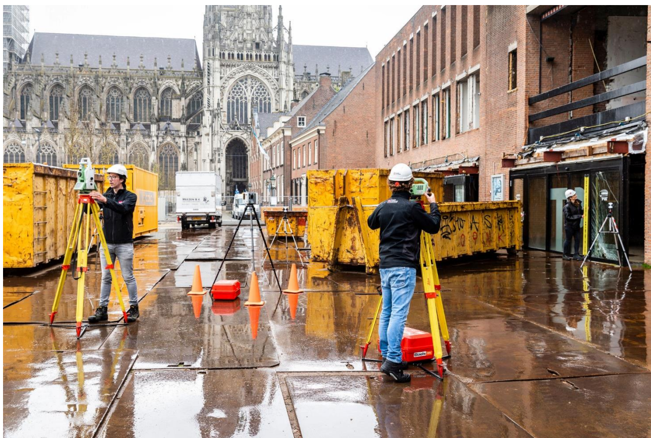
Monitoring rondom bouwplaats Theater aan de Parade te 's-Hertogenbosch met combinatie van laserscanners, hoog nauwkeurige total stations, trillingsmeters en tilsensoren.
